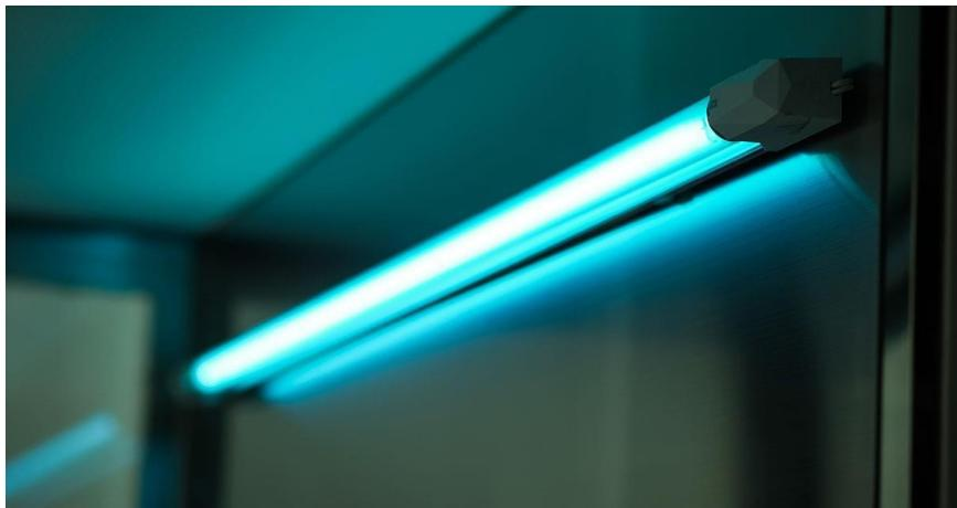
UV lampe (254 nm, 50kW) se redovno koriste za sterilizaciju vazduha u komori i patogene koji uzrokuju bolest. Svaka UV lampa ima dva UV radijatora.
